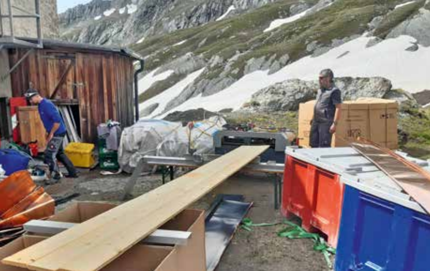
▲ Zusägen der Trägerkonstruktion für die PV-Anlage auf der Sudetendeutschen Hütte
