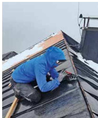
▼ Vorbereitende Arbeiten für eine PV-Anlage auf dem Dach der Sudetendeutschen Hütte
